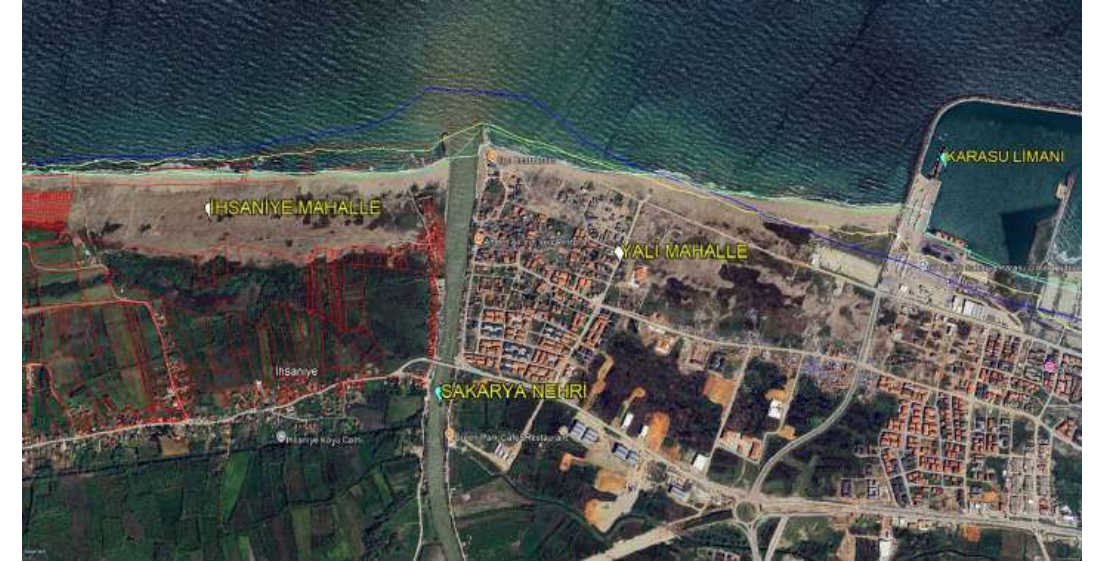
Karasu – Yenimahalle (kıyı erozyonu)
